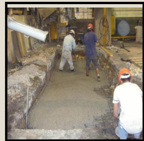
FOSA DE EQUIPOS MECÀNICOS
