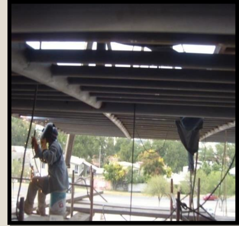
ESTRUCTURA ROLADA EN FACHADA PRINCIPAL/Herreria/
