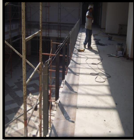
ESTRUCTURA ROLADA EN FACHADA PRINCIPAL/Herreria/
