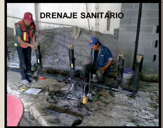
CONEXIÓN MÚLTIPLE DE DRENAJE SANITARIO MARCA GEBERIT YA INSTALADO
